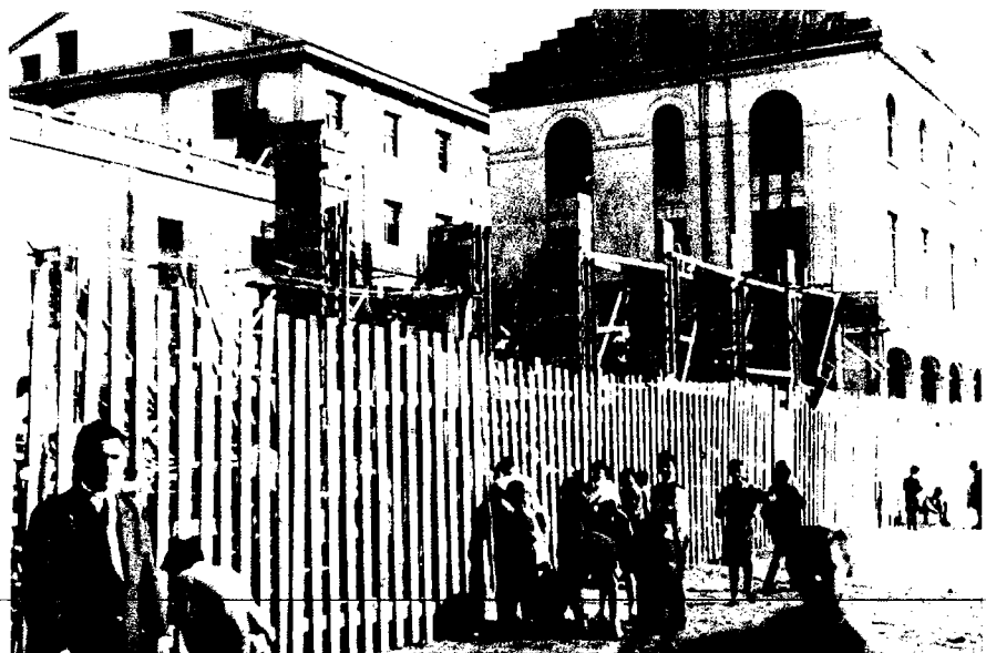
El edificio del nuevo teatro en construcción. Año 1949.
