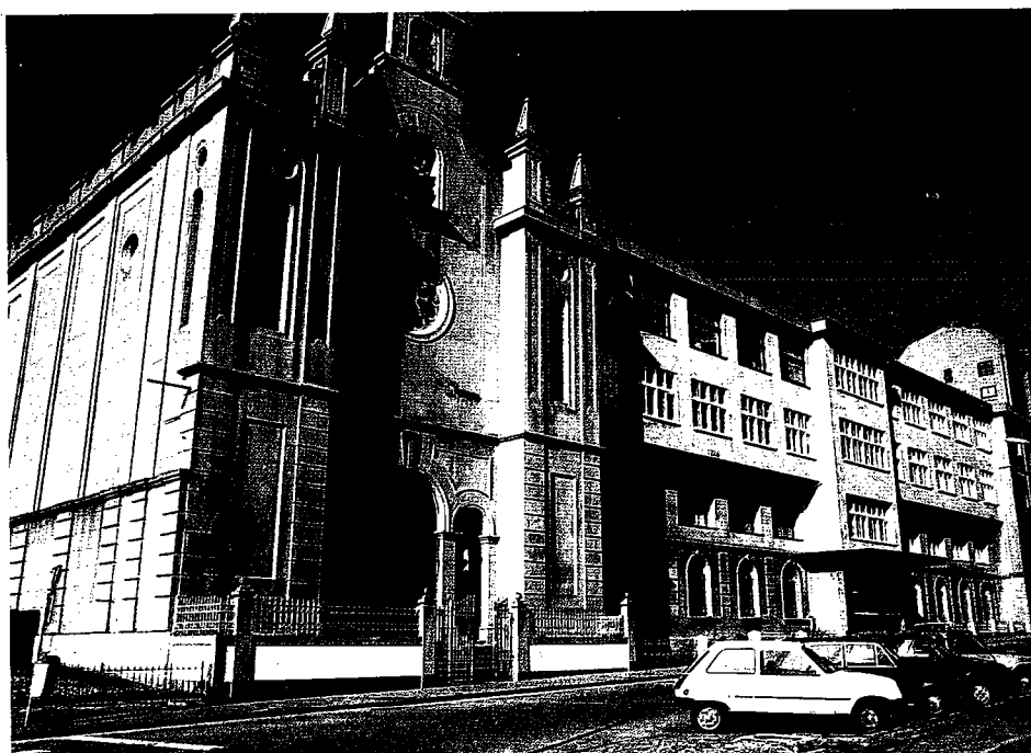
Fachada principal del Colegio Salesiano "San Juan Bosco"
